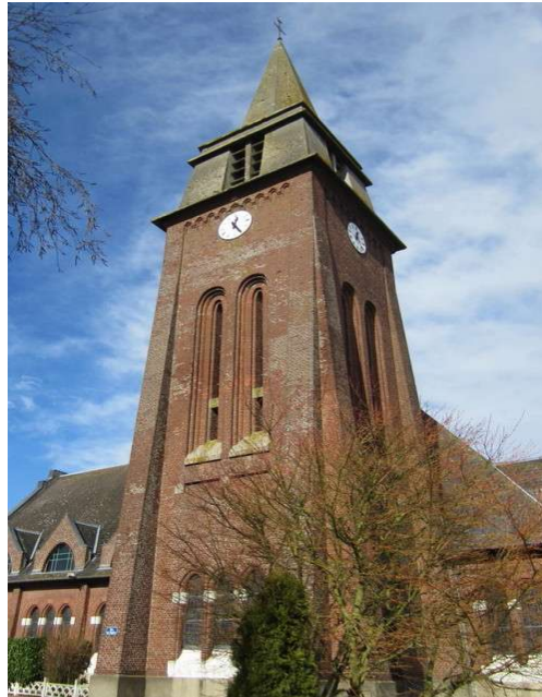
Eglise de Bertincourt (62) en avril 2014
