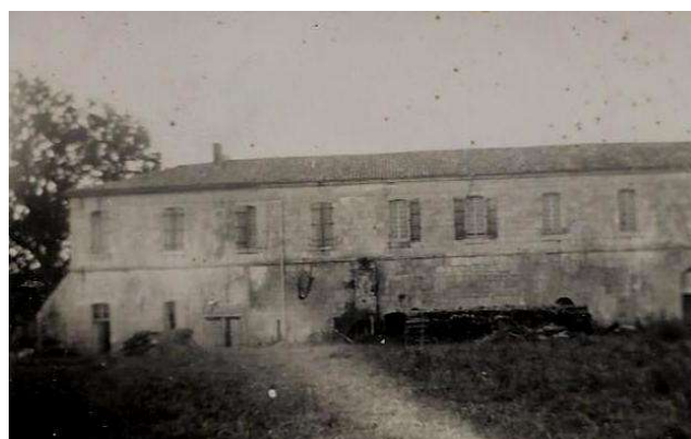
Arrière de l' aile du Prieur entièrement démolie et aile aux moines en septembre 1945.
