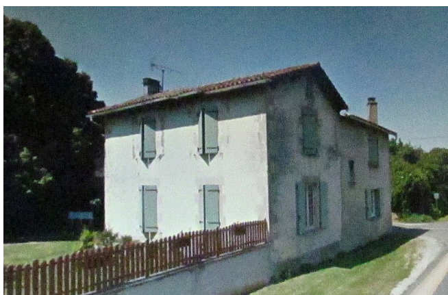
1ère maison bâtie par les Meunier
