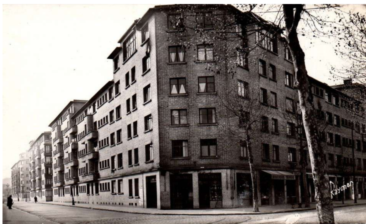
La Cité HBM à l'angle de la rue E. Duclaux et de l'avenue P. Grenier en 1950
